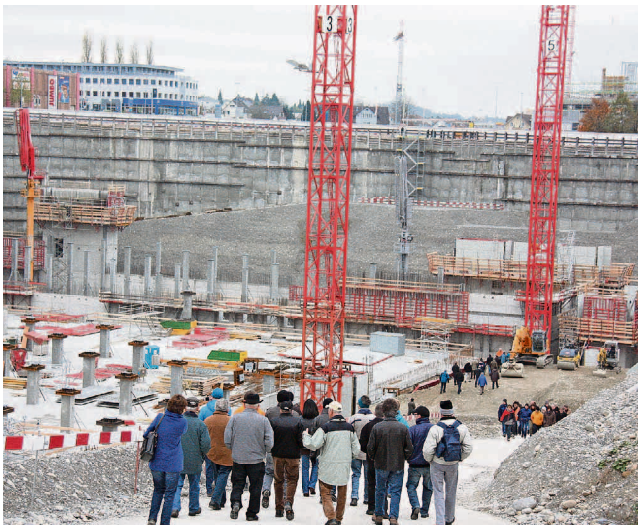
Viele Einwohner von Schafisheim ergriffen die Gelegenheit, um den Bau an der Aarauerstrasse zu besichtigen.
